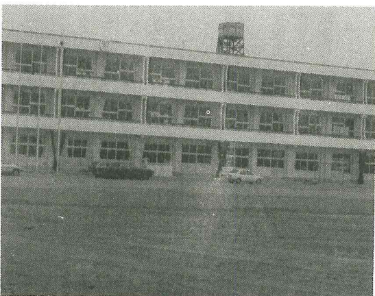
新築された福岡中学校
