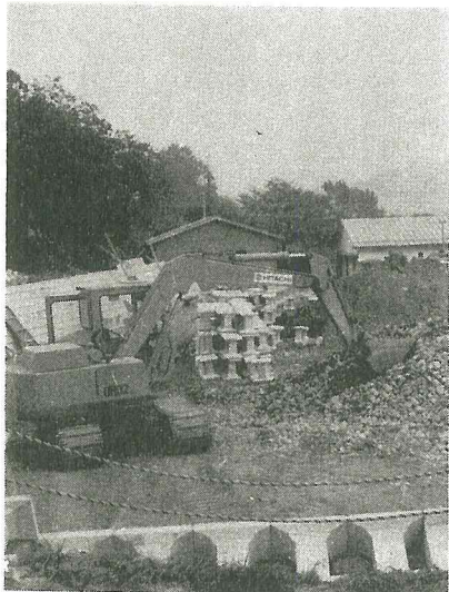
越河公民館建設地
