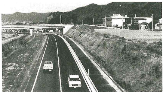
完成した白石バイパス
