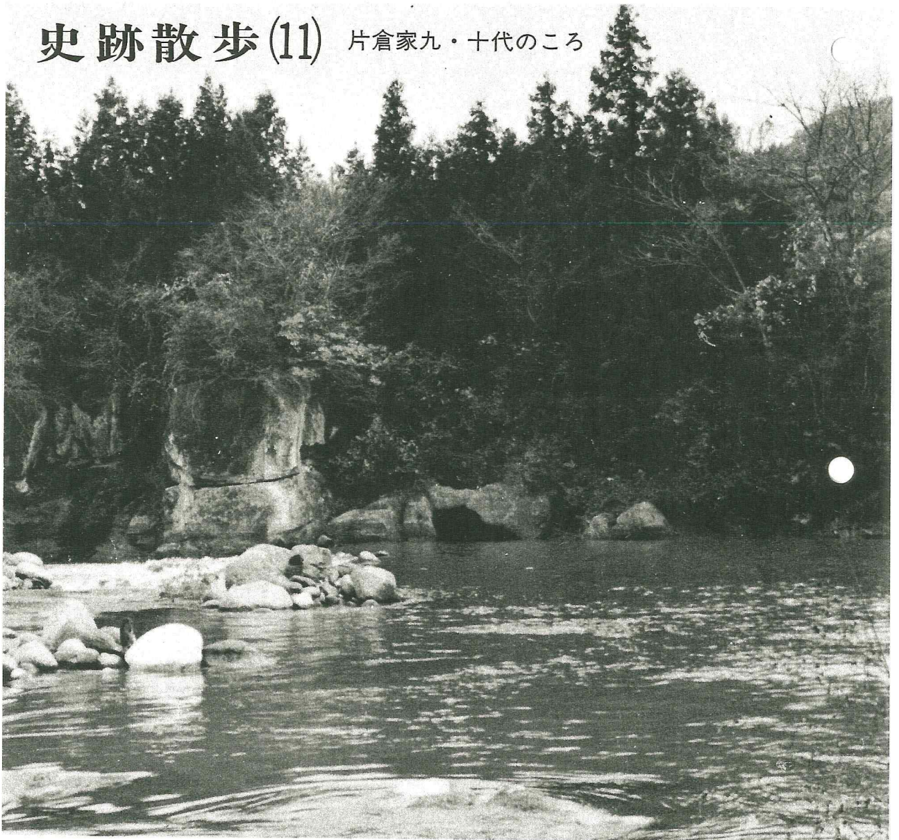
旧白石大堰取入口
