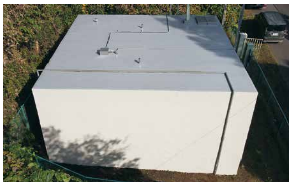
▲屋上の防水と外壁の塗装を行い、修繕完了
