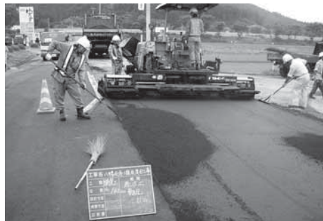
▲応急復旧工事の様子
