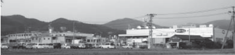
▲蔵王工場の外観
