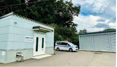
▲大町ポンプ場と備蓄倉庫
