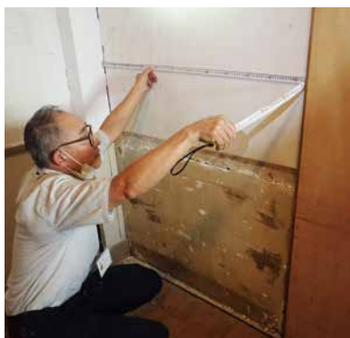
▲深谷小学校体育館内壁の損傷範囲の計測
