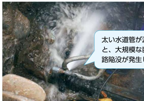
太い水道管が漏水すると、大規模な断水や道路陥没が発生します。
