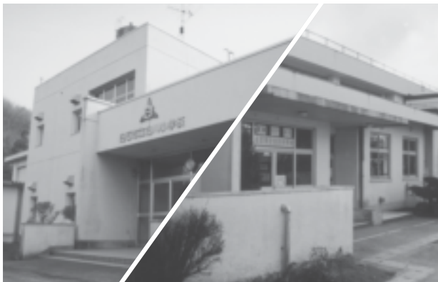
▲耐震補強工事を実施する白川小学校（左）と白川中学校（右）
